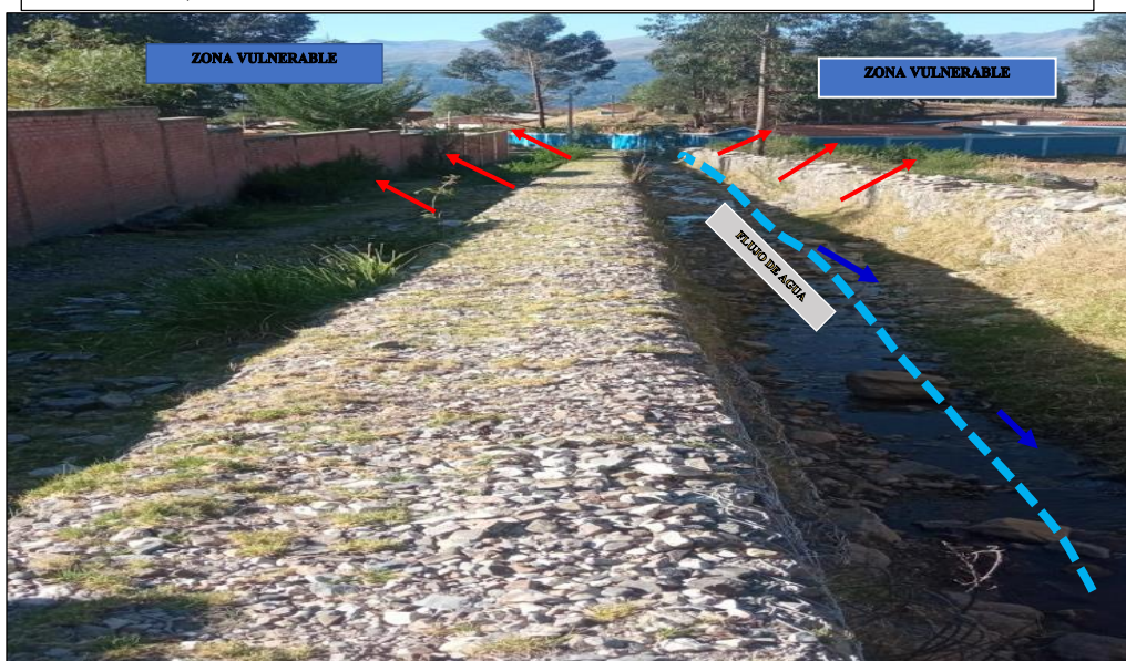
FIGURA N°02: CAUCE DE LA QUEBRADA MASQUI CON TRAMO CON GAVIONES, SIN EMBARGO, SE ENCUENTRA EN MAL ESTADO CON EROSION EN LA BASE, EN EL SECTOR MASQUI, DISTRITO DE LUCMA, PROVINCIA DE MARISCAL LUZURIAGA - ANCASH.
